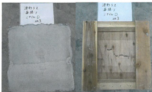
ラスモルタル外壁面
