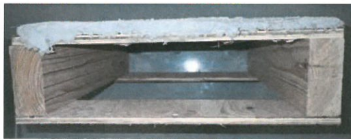
写真8 ラスモルタル直張り構法
