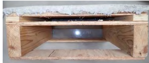
写真9 ラスモルタル二層通気構法
