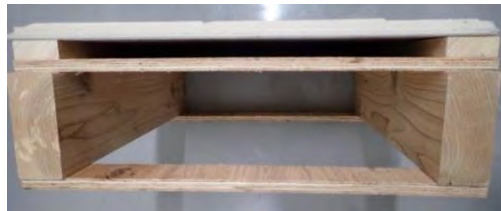
写真10 窯業系サイディング二層通気構法
